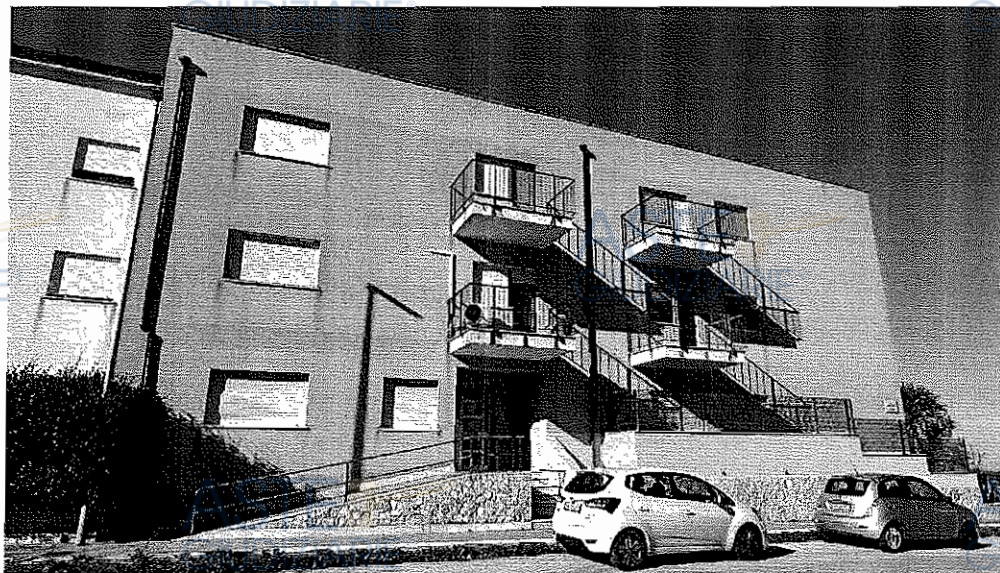
FOTO 1 - PORZIONE PROSPETTO VIA DON G. GIARDINA
