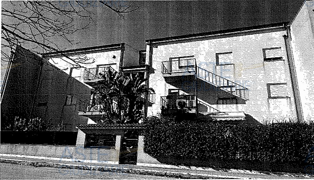
FOTO 1 - PROSPETTO VIA DON G. GIARDINA
