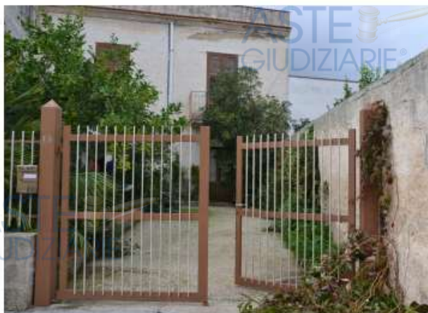
Ingresso edificio dalla via G. Verga
