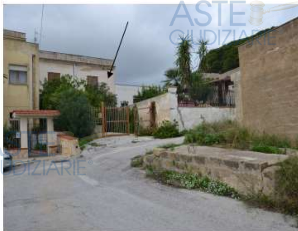
Vista dell'edificio dalla via Capuana
