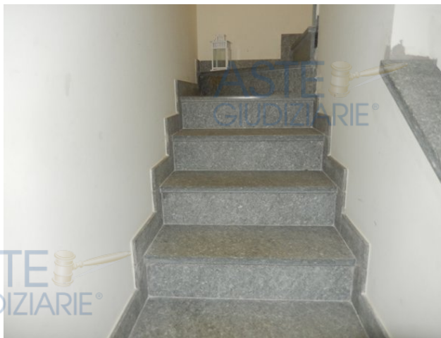
Scale interna di accesso al piano interrato
