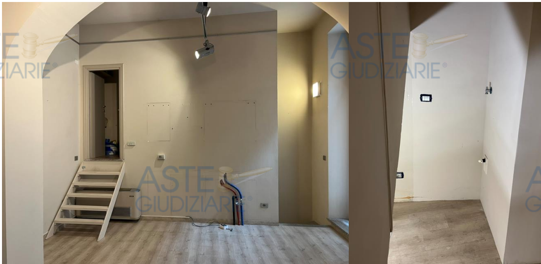
RIPOSTIGLIO REALIZZATO AL PIANO TERRENO SOPRA LA SCALA (A)
