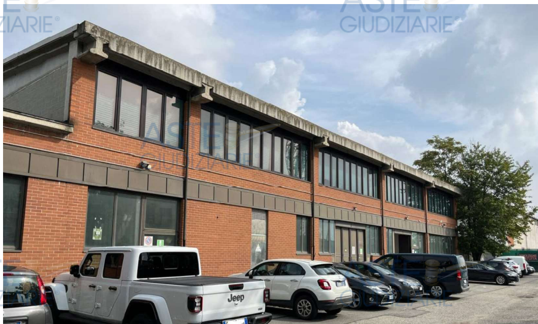
Figura 3 – FACCIATA A SUD-OVEST
