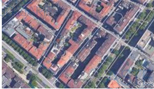
INQUADRAMENTO GENERALE - TORINO VIA MASSENA 103
