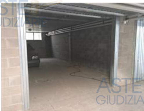
rimessa al piano interrato
