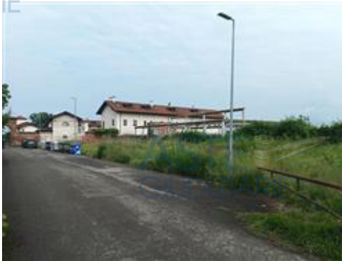
veduta da est dell'area, con servitù di passaggio (mappale n. 181)
