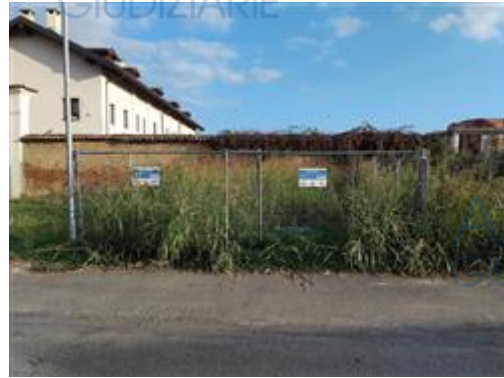
veduta sito servitù da serbatoi gas interrati (mappale n. 181)
