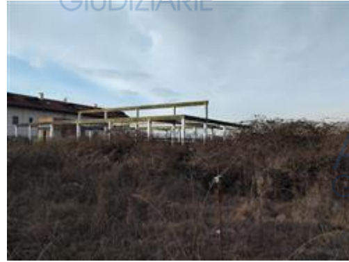
Veduta da sud-est della struttura verticale esistente sull'area (mappale n. 182)
