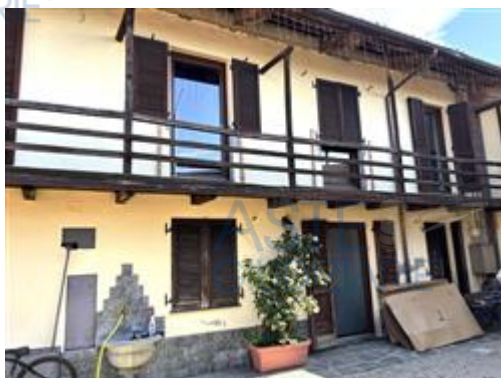
Vista della facciata principale
