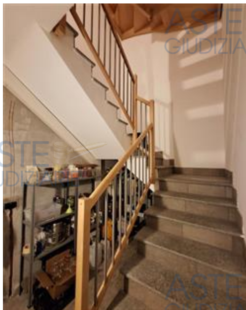
Scala in pietra dal piano seminterrato al piano rialzato
