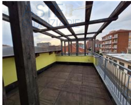
terrazzo all'ultimo piano, destinato a giardino pensile e non ancora completato
