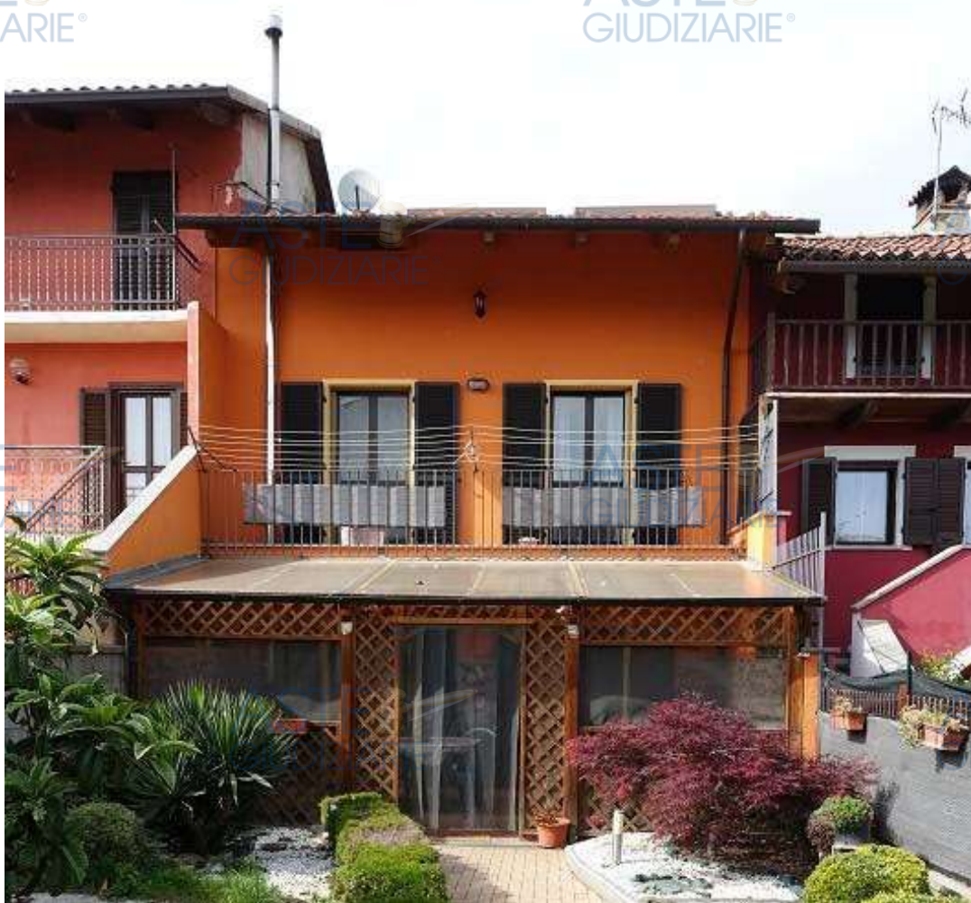
Fig. 4 – La facciata lato sud dell'immobile residenziale
