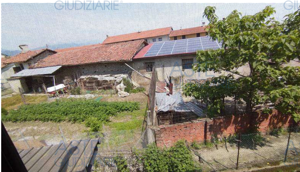
Fig. 19 – Vista dalla finestra del bagno sul lato nord
