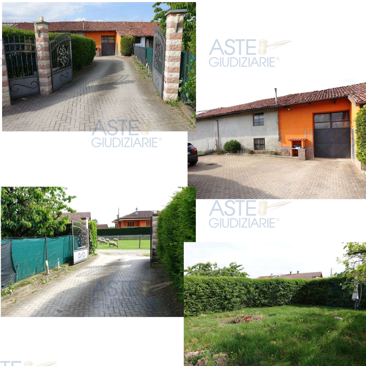
Fig. 31 – Vari scorci dei terreni pignorati: si osserva il cancello di ingresso all'area antistante la tettoia pignorata (individuabile dal muro di color arancione), una zona di parcheggio per autovetture, ed un settore a prato
