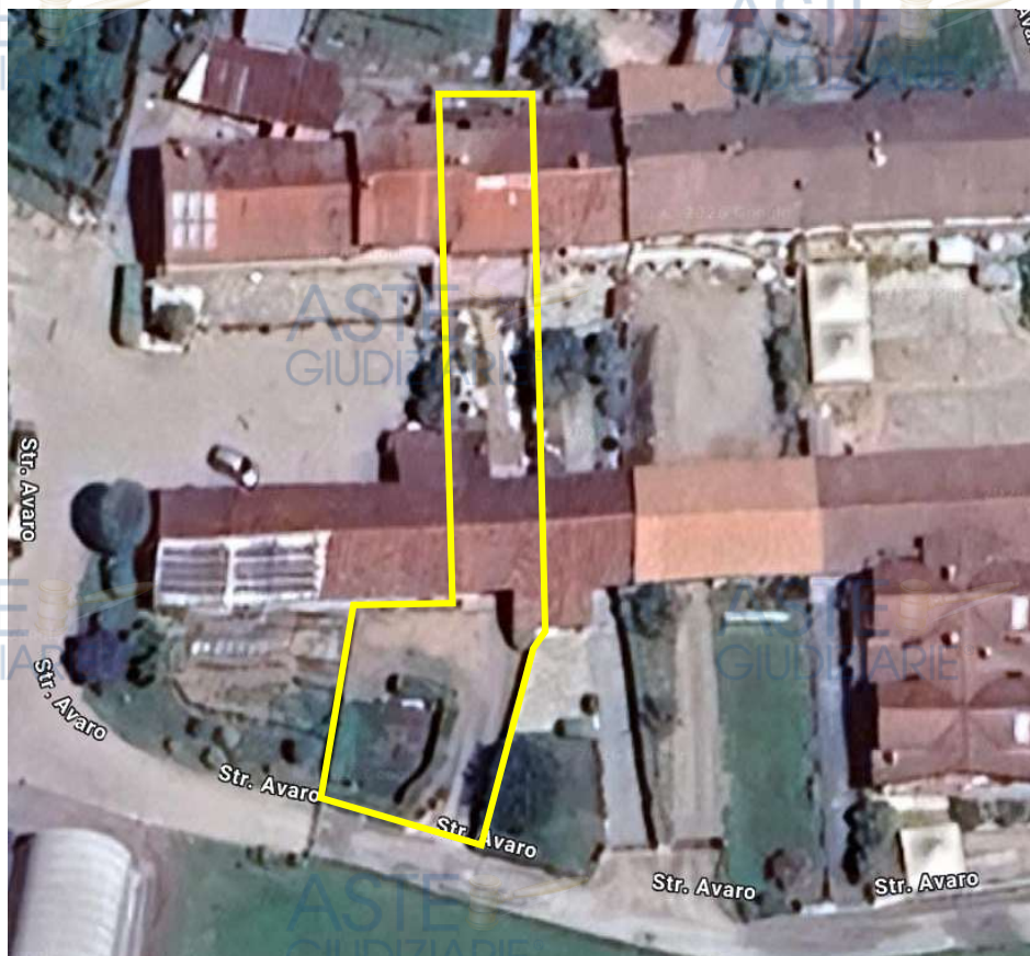
Fig. 3 – Vista aerea degli immobili pignorati (fonte Google Earth)
