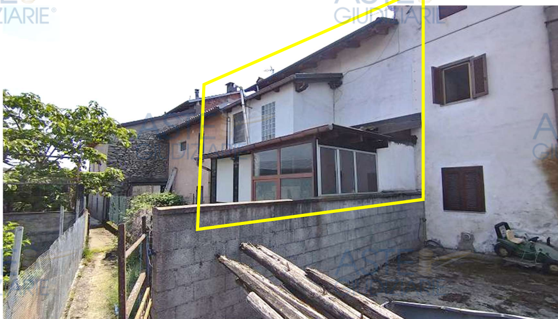
Fig. 5 – La facciata retrostante lato nord
