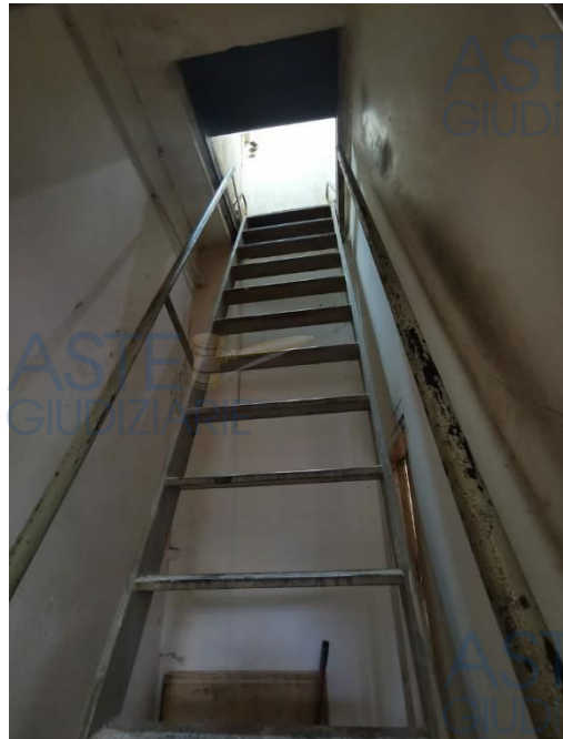
Scala interna collegamento al negozio (di cui al punto A)
