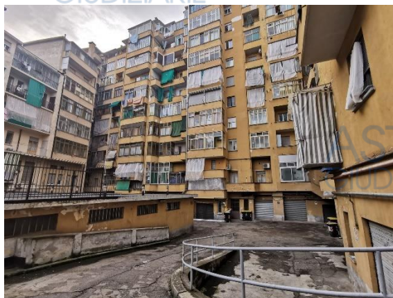
Facciata cortile condominiale
