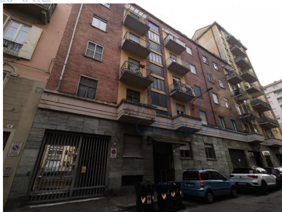
Facciata condominiale su Via Stellone n. 2
