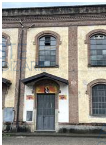
particolare della porta di ingresso all'immobile
