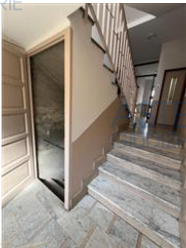
vista dell'ingresso al piano cantinato
