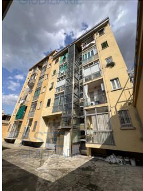
vista del prospetto verso il cortile comune
