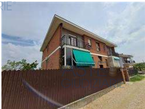
Prospetto lato strada
