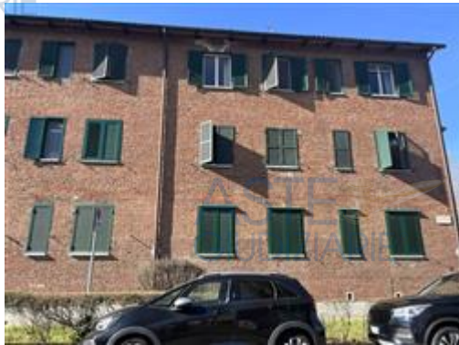
FACCIATA SU VIA PUBBLICA
