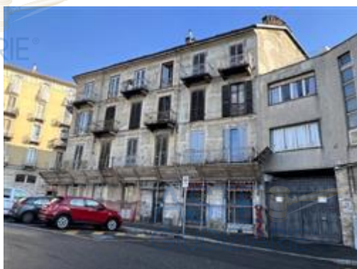
vista della facciata verso via Stradella
