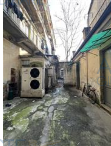
vista della prima porzione di cortile interno
