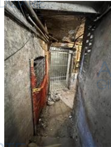
vista dell'ingresso al piano interrato
