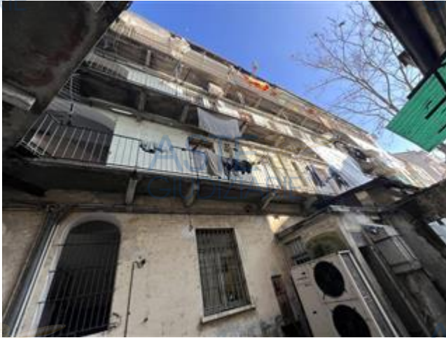
vista della facciata verso il cortile interno
