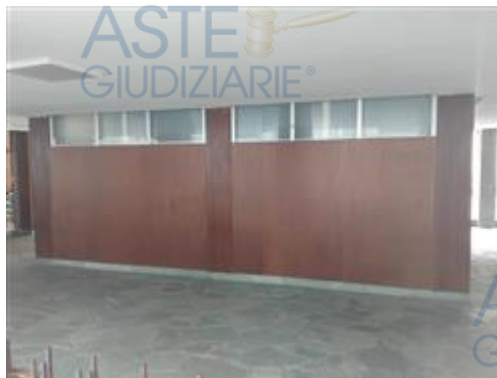
veduta esterna dell'unità (ex alloggio custode) al piano pilotis, oggetto di pignoramento
