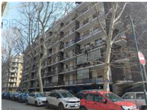
veduta facciata su via Lanfranco dell'edificio
