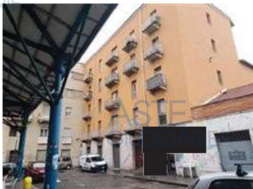
prospetto lato strada
