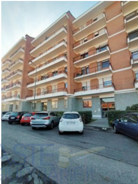
Immobile visto da via Valfrè
