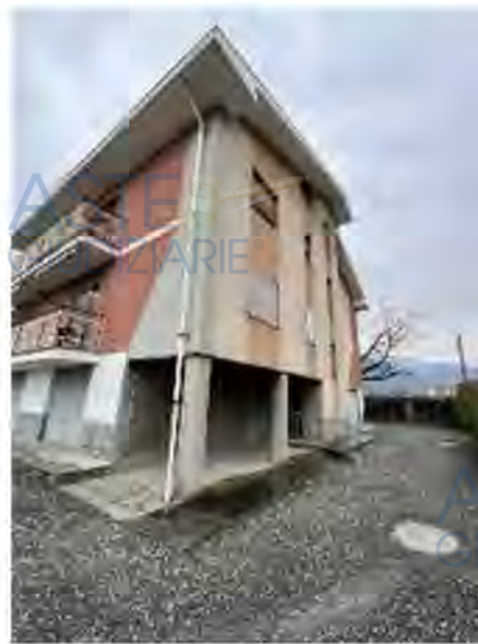
Porticato di accesso al vano scala
