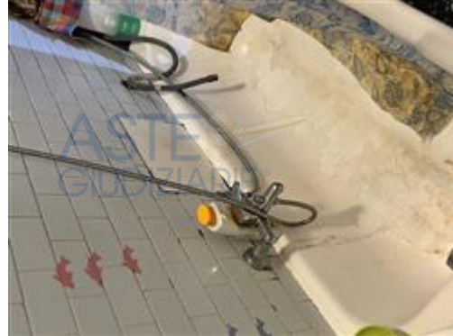
Particolare gruppo vasca - impianto idrico
