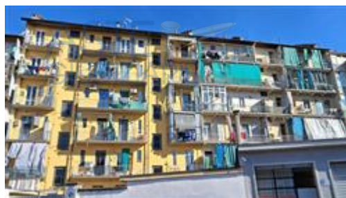
FACCIATA LATO CORTILE
