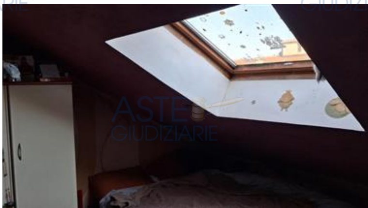
SOFFITTA - FINESTRA A RASO TETTO
