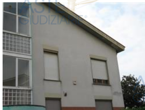
vista esterna dell'edificio - dettaglio
