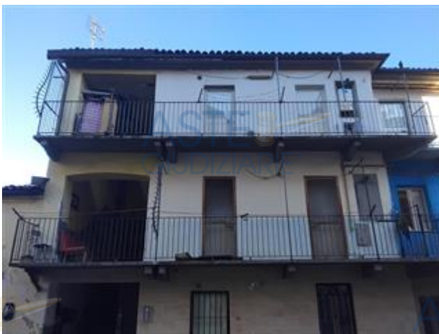
Prospetto sud, su cortile comune, dell'edificio
