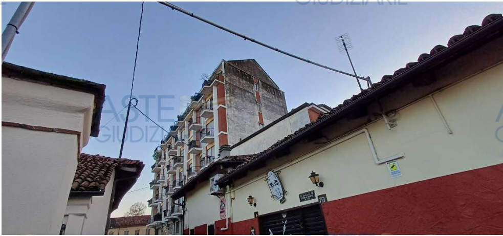
Fig. VII - VEDUTA FACCIATA LATO NORD DELL'EDIFICIO
