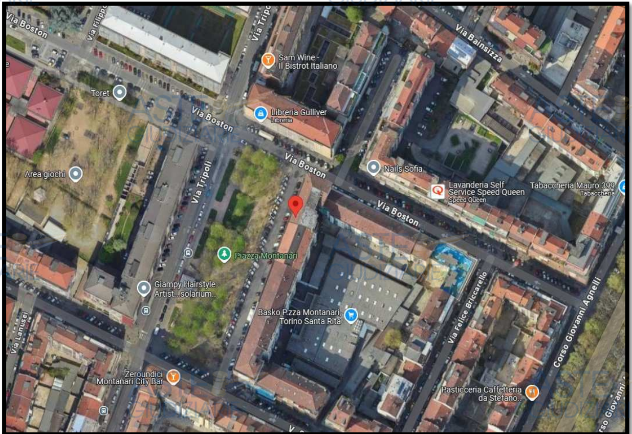
Fig. 1 - Complesso condominiale di cui fa parte l'immobile pignorato Piazza Montanari Carlo n. 131 – Torino (TO) – (fonte google maps)
