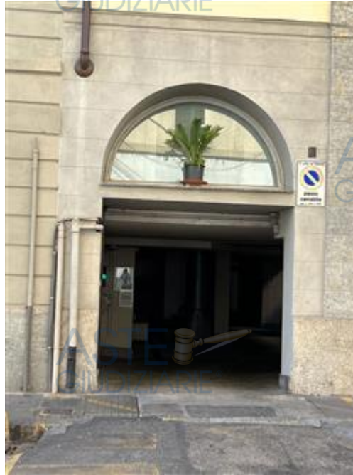
vista del portone di ingresso al cortile comune ed all'autorimessa
