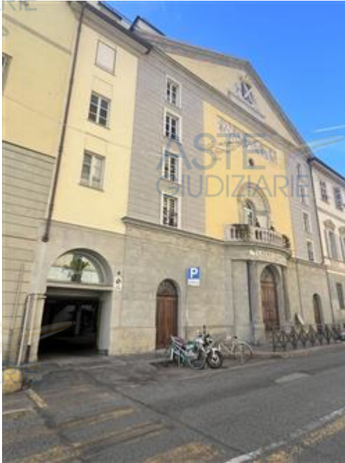
vista della facciata sulla via Principe Amedeo
