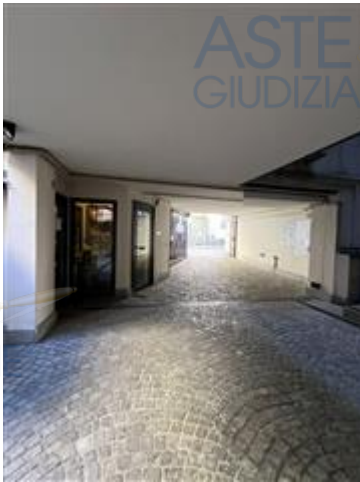
vista dell'androne di ingresso dalla via Principe Amedeo e del locale portineria posto sulla sinistra
