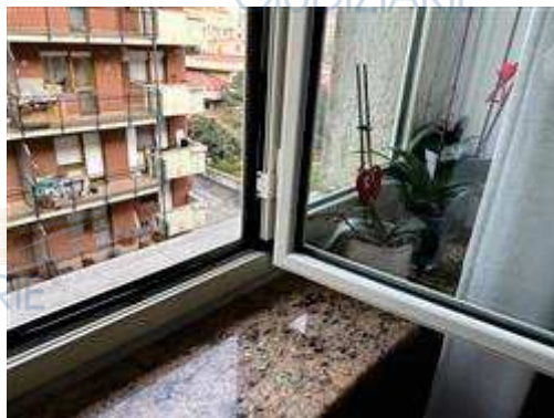
Particolare dei serramenti esterni.
