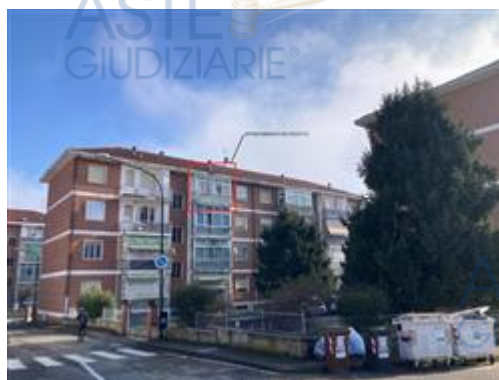
Facciata lato cortile condominiale
