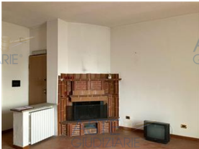
Irregolarità tramezzature interne
