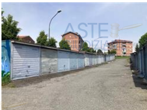
Area esterna blocco autorimesse
