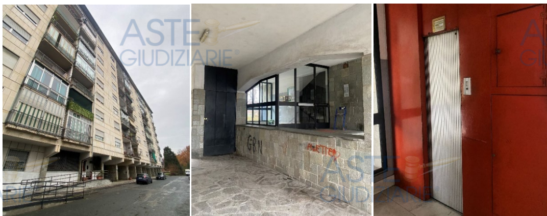
Vista dall'esterno – vano scala – ascensore
