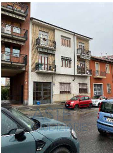
Facciata su via Rovereto
