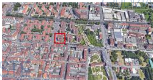
Foto aerea della zona
