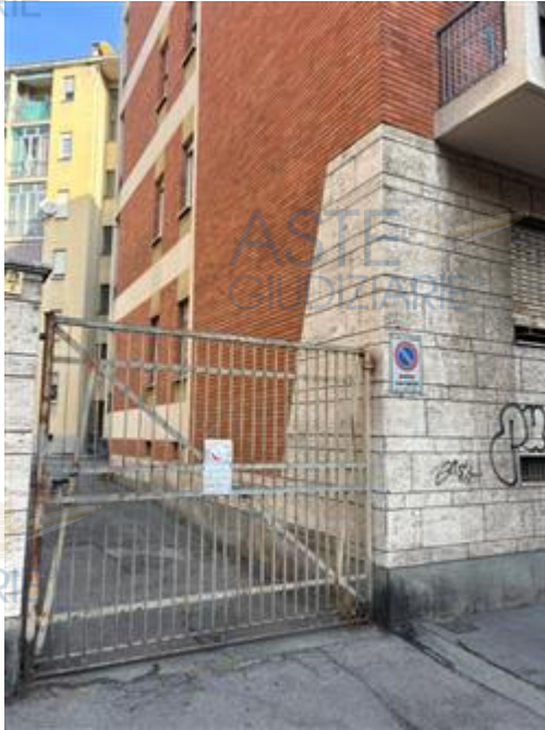
Dettaglio facciata verso corsia d'ingresso al cortile interno
