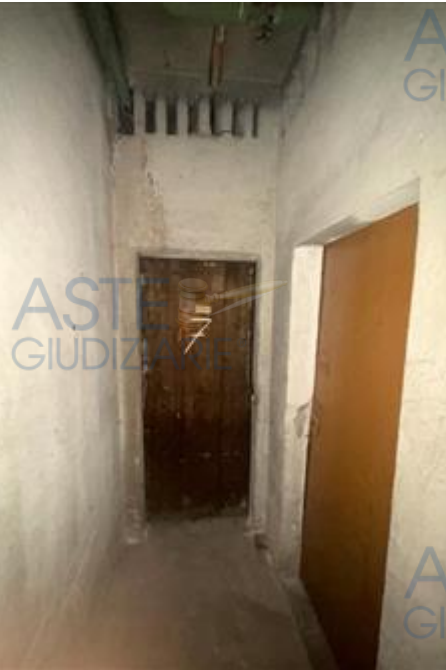
Porta ingresso cantina
