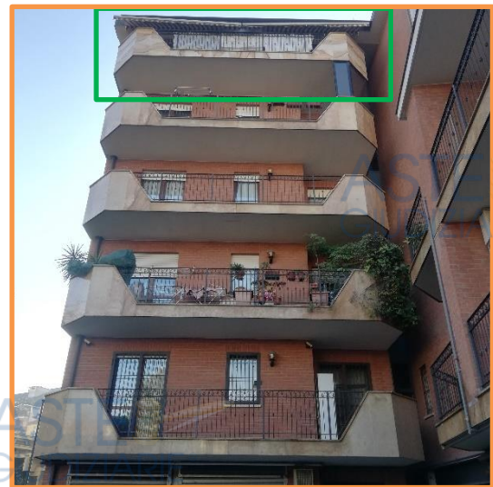
Prospetto lato cortile interno
