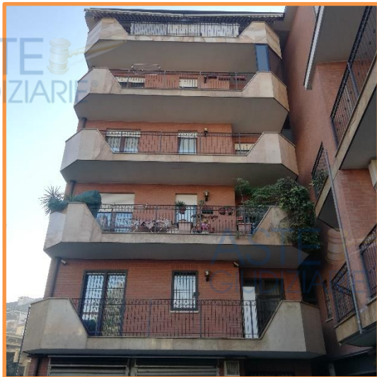
Prospetto lato cortile interno
