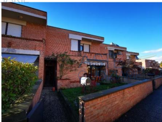
Facciata principale, ingresso da vialetto pedonale condominiale
