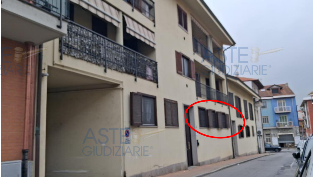
Foto 1 prospetto edificio via Vittorio Veneto
