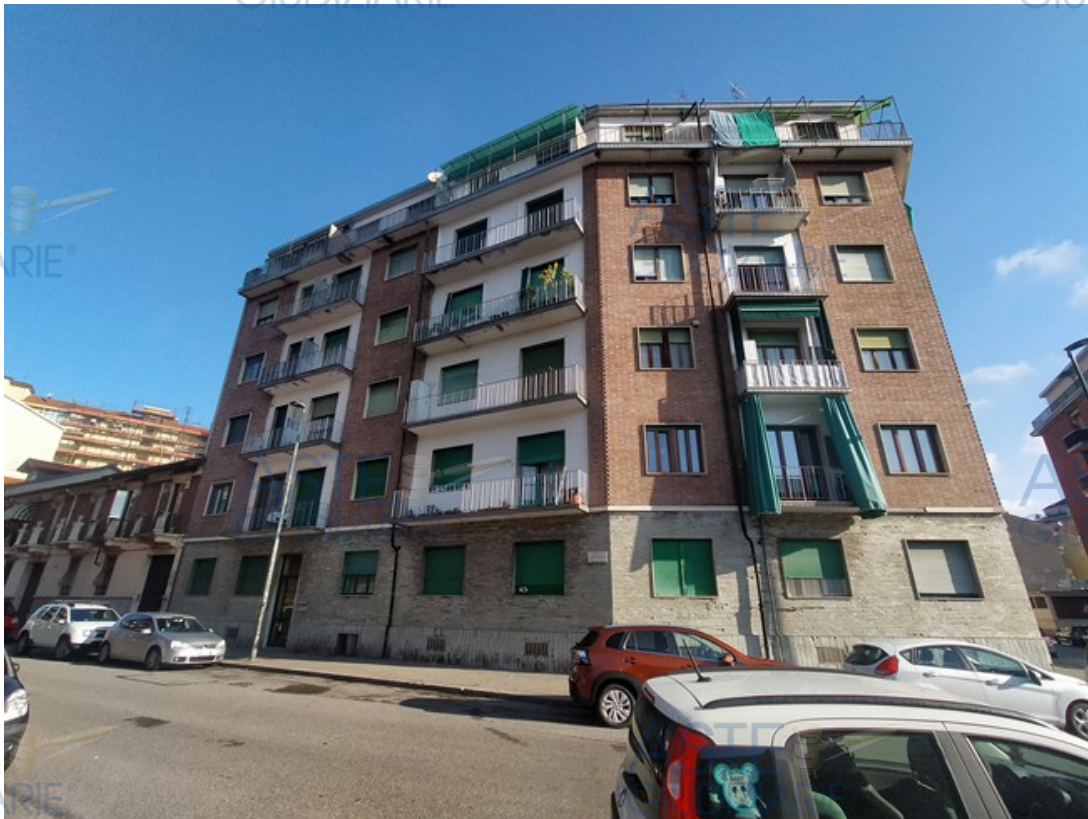
Immobile condominiale visto da Via Boito
