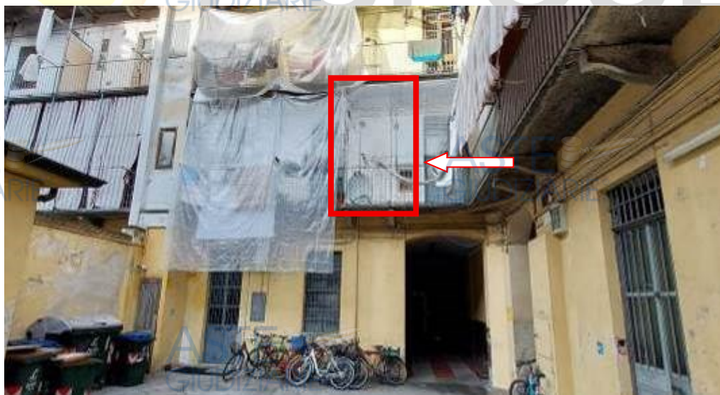
Identificazione dell'alloggio lato cortile – accesso da ballatoio P1
