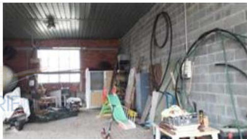
TETTOIA CHIUSA - INTERNO
