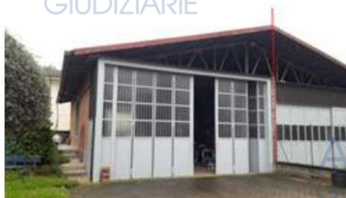
TETTOIA CHIUSA - PORZIONE LATO SINISTRO
