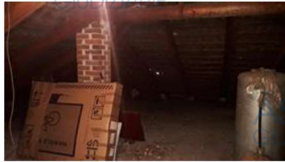
SOTTOTETTO COMUNE A TERZI
