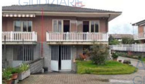
LATO SUD - INTERNO CORTILE
