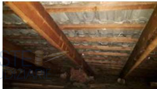
SOTTOTETTO COMUNE A TERZI
