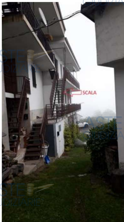
SCALE ACCESSO AL PIANO SECONDO
