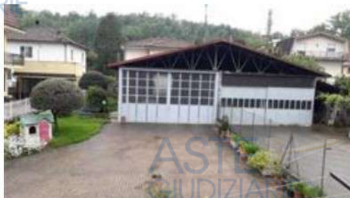
TETTOIA CHIUSA - PORZIONE LATO SINISTRO
