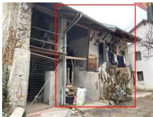
Vista fabbricati 1b - 2 - 3 - Vaie
