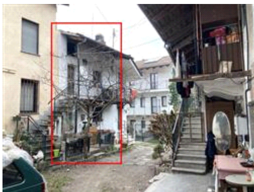
Vista fabbricato residenziale 1a - Vaie
