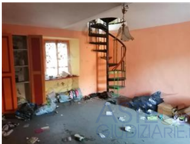
Veduta interno cucina, al piano primo
