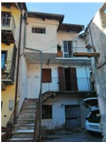
Prospetto nord-est dell'immobile pignorato
