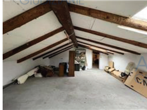
vista del sottotetto
