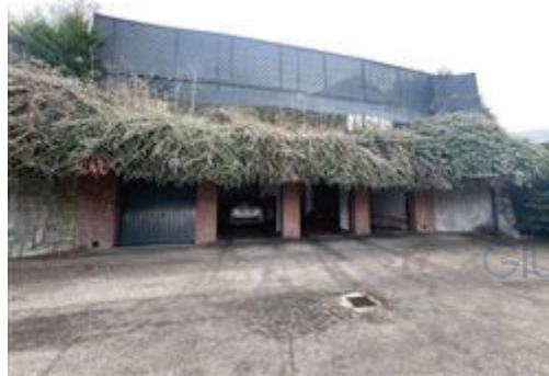
vista esterna dell'immobile
