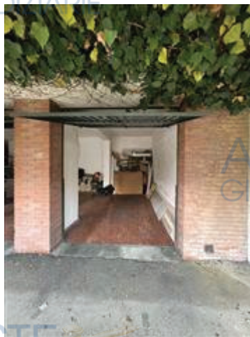
particolare di entrata ad una delle campate
