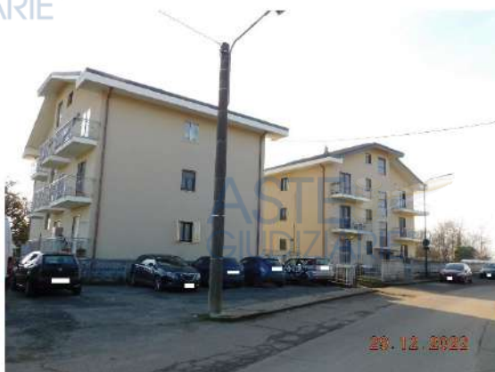
figura - vista generale del complesso edilizio
