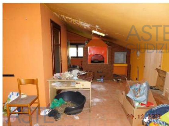
figura - vista parziale locale sottotetto e servizio igienico
