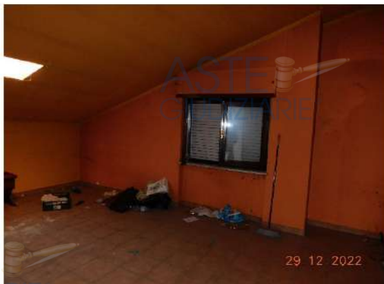
figura - vista parziale locale sottotetto
