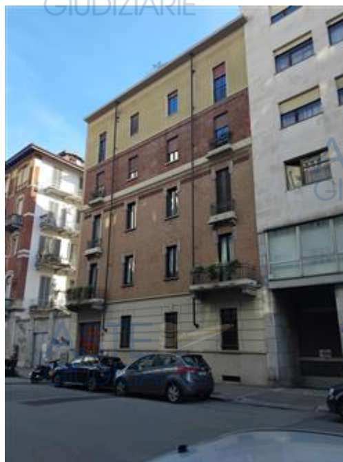
Veduta del condominio da via Torricelli
