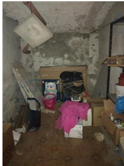
veduta interno cantina al piano interrato
