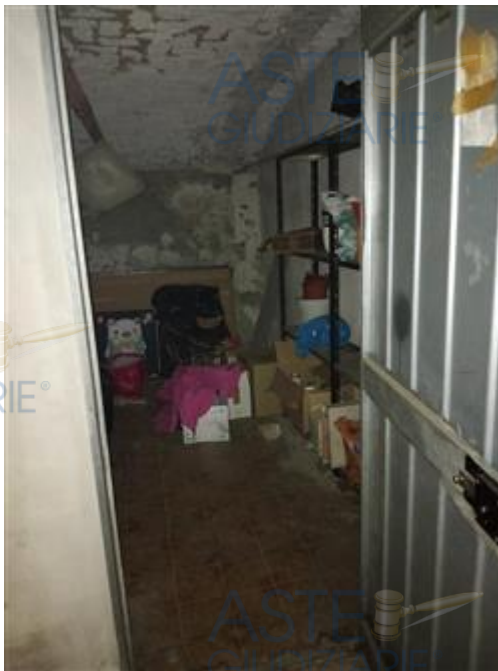
veduta porta di accesso e interno cantina al piano interrato
