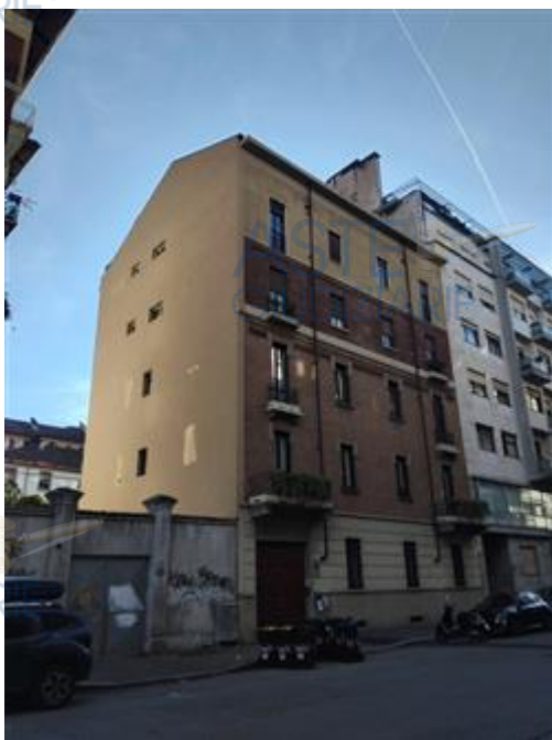
Veduta del condominio da via Torricelli
