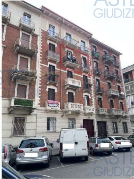
vista della facciata su via Bairo
