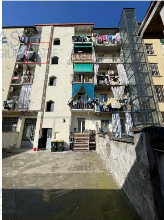
Vista dal cortile
