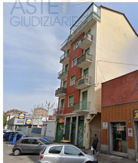
Figura 6 – edificio in via Aosta n. 20bis
