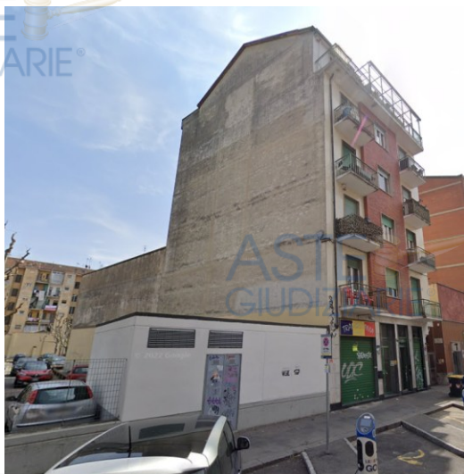
Figura 5 – edificio in via Aosta n. 20bis
