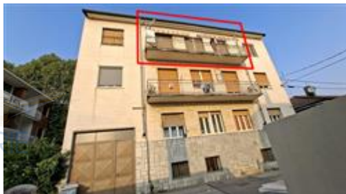
FACCIATA ESTERNA FRONTE VIA PASTRENGO
