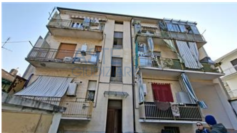
FACCIATA INTERNA CON INGRESSO AL VANO SCALA
