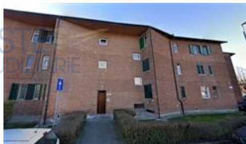
Facciata ingresso condominiale
