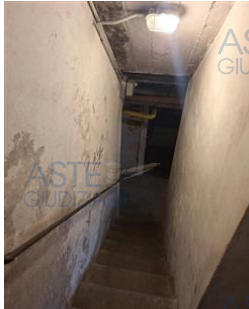
scala di accesso alle cantine
