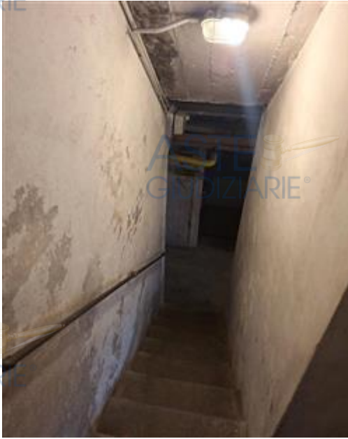
scala di accesso all'interrato, alle cantine
