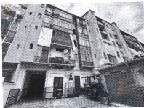
Prospetto lato cortile
